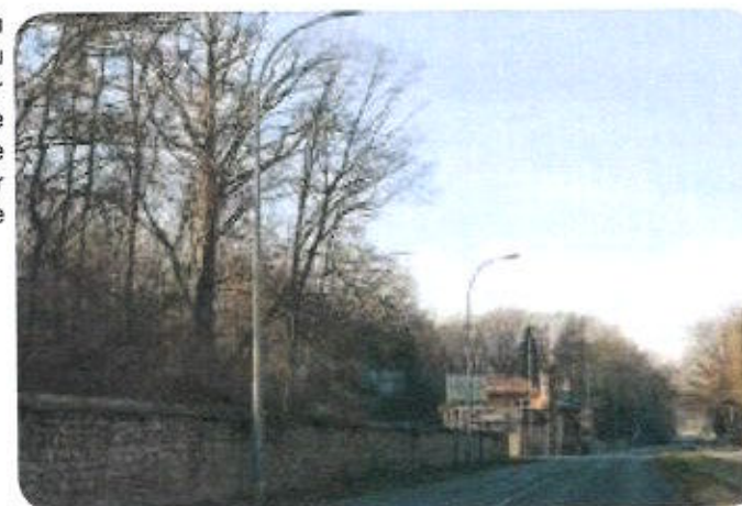
Fig. 115. Le parc du Château du Mée
