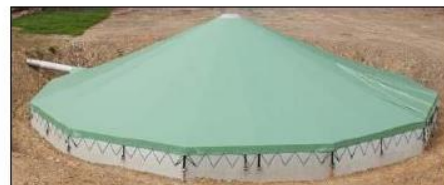
Couverture des fosses de stockage
