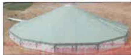
Couverture des fosses de stockage
