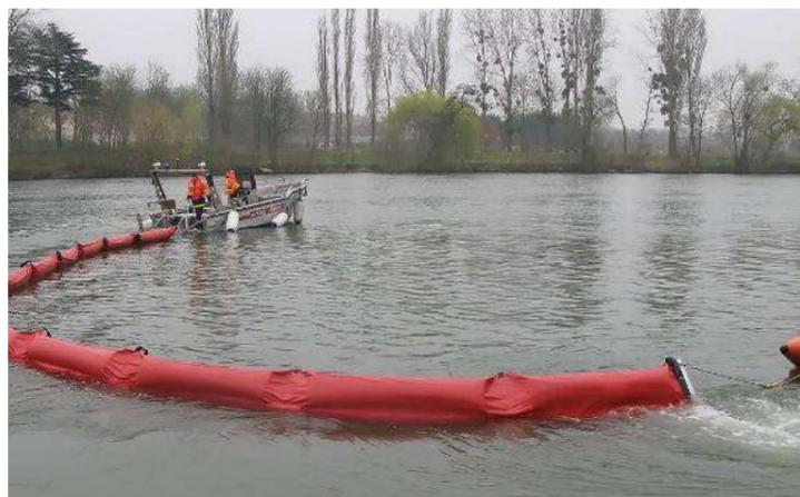
Figure 15 : Déploiement d'un barrage flottant
