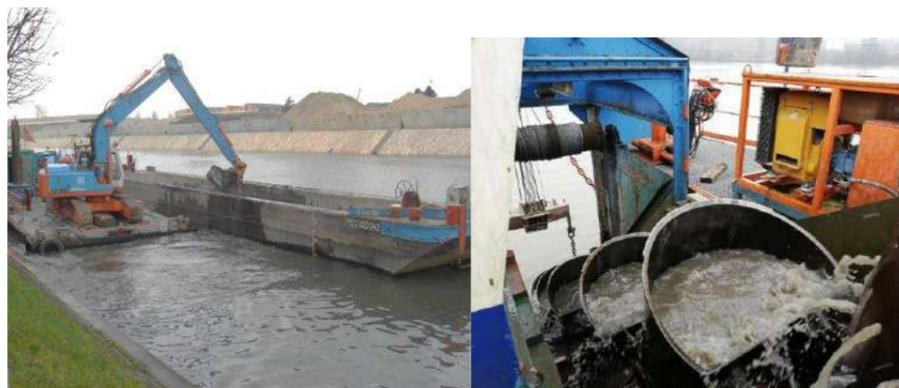
Figure 3 : Atelier dipper et godet d'une drague
